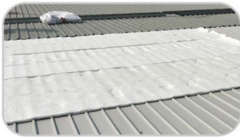
防火陶瓷棉 一片尺寸(成捲) 600x7200x25mm(寬x長x厚)
