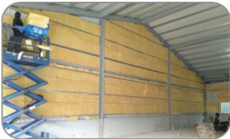
防火玻璃棉:一包八片,可做面積5.76 M 2 一片尺寸: 600x1200xt10 mm(寬x長x厚)
