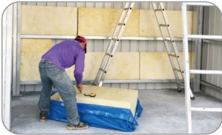
防火玻璃棉:一包八片,可做面積5.76 M 2 一片尺寸: 600x1200xt10 mm(寬x長x厚)
