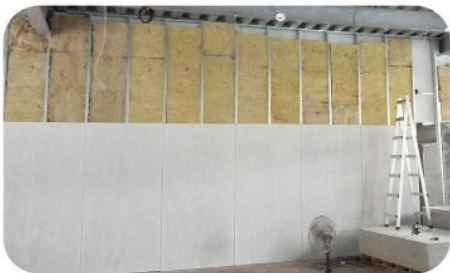
矽酸鈣板一片尺寸：3x6尺 / 4x8尺/30kg 防火岩棉：一包六片 一片：600x1200x10mm(寬x長x厚)
