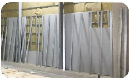
矽酸鈣板一片尺寸：3x6尺 / 4x8尺/30kg 防火岩棉：一包六片 一片：600x1200x10mm(寬x長x厚)
